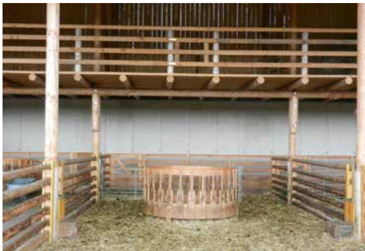
Eine Strohbühne ermöglicht es, trockenes Einstreumaterial direkt im Stall zu lagern und von oben einzubringen.
